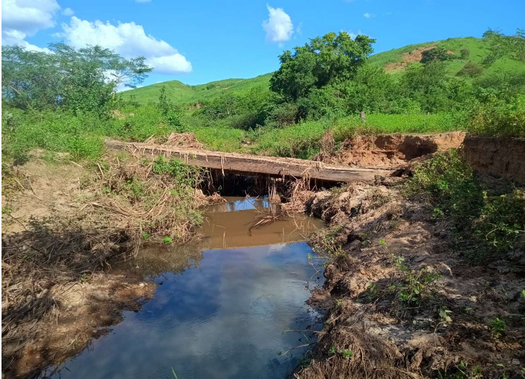
Foto 4 – Sentido à Jusante
