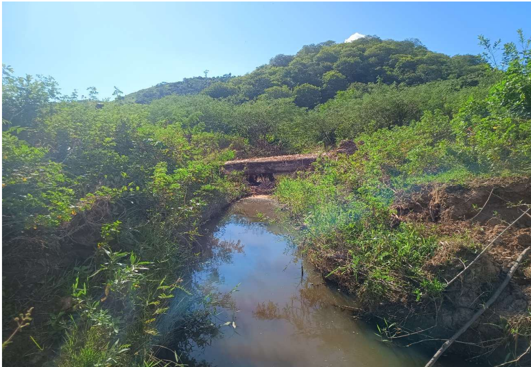
Foto 4 – Sentido à Jusante
